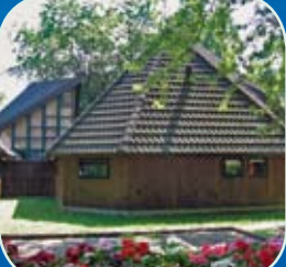
ÁTRIUM HÁZ ATRIUM HOUSE
